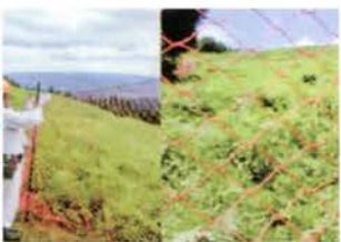
⑥ ネットの間隔の決定 ネットの目合い、支柱の間隔を見ながら支柱間のネットの間隔を決定します。設置後の目合いが正方形になるように調整します。
