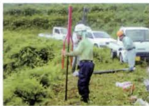
② 支柱の打ち込み 打ち込み器を使用し、支柱を打ち込みます。
