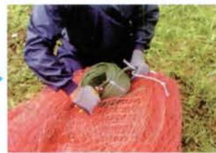
③ 吊りロープ・押さえロープの通し込み ガイドロープを利用してネットへ、吊り・押さえロープを通し込みます。
