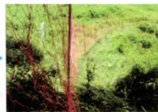
⑧ 設置状況 設置完了。
