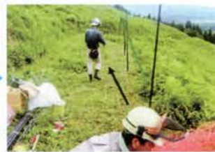
④ 布設の準備 吊りロープ、押さえロープが絡まないように約50mロープを伸ばしきります。
